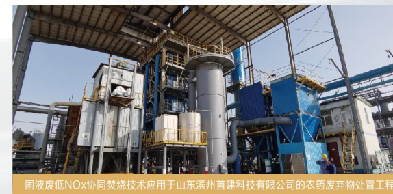
国液度低NOx协同焚烧技术应用于山东滨州首建科技有限公司的农药废弃物处置工程
